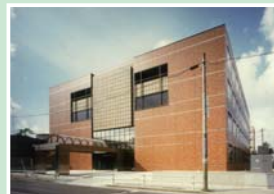
移設した頃の本部棟外観
